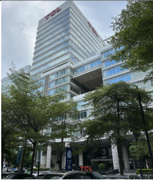
项目厂房外观
